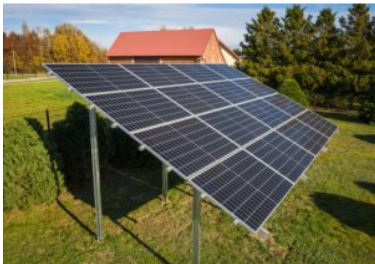
Fotowoltaika na gruncie – stelaż naziemny.
