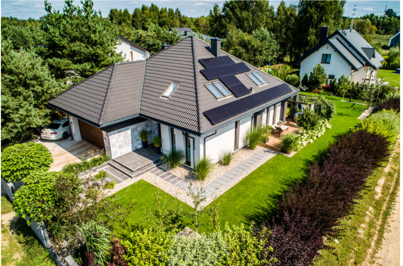
Instalacja na dachu domu Pana Pawła z Ignatek k/Białegostoku
