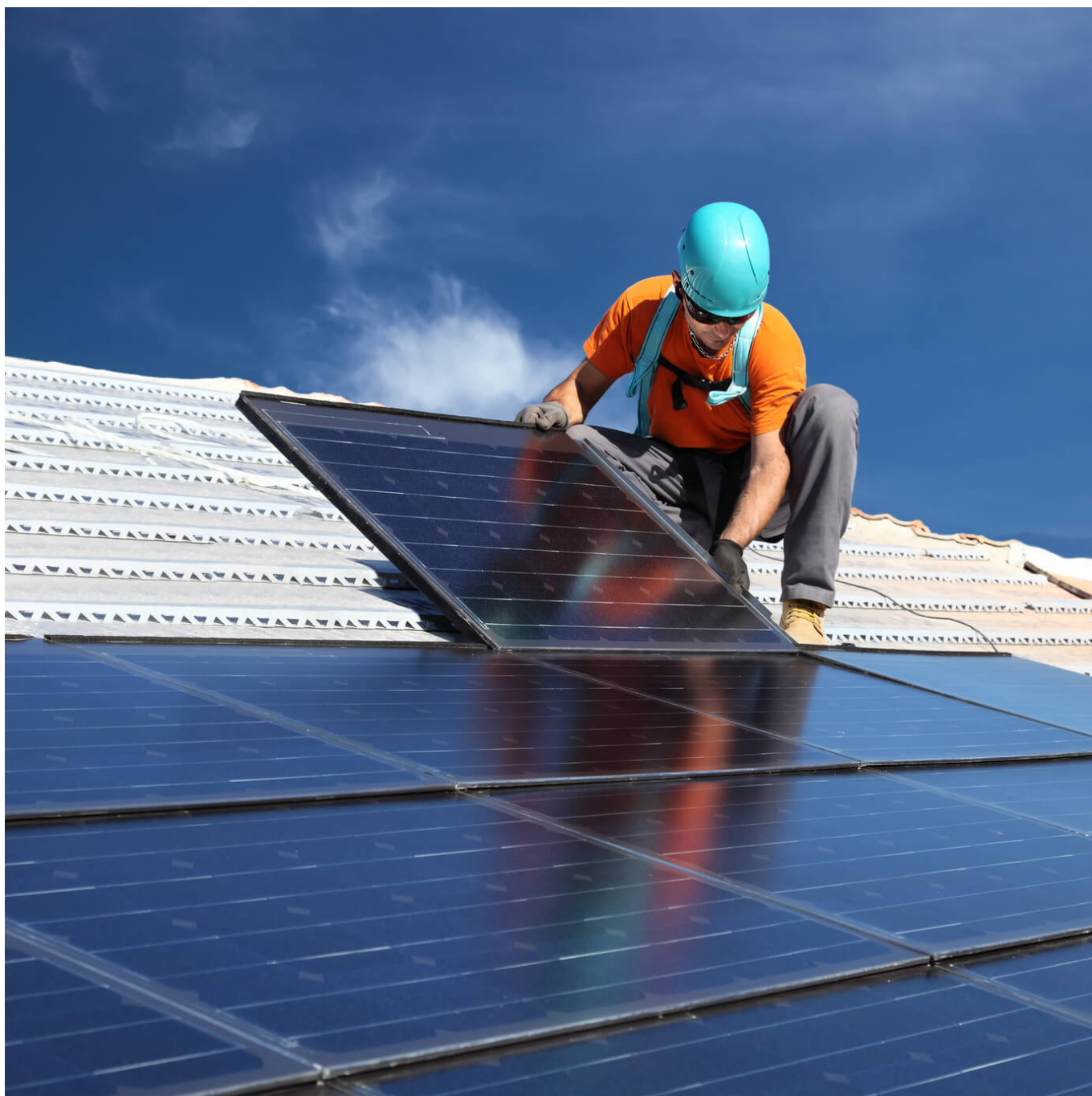
Instalacja fotowoltaiczna - montaż
